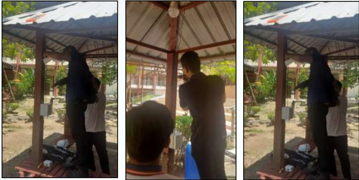
Gambar 1: Proses pemasangan sistem solar di wakaf.
